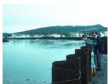
Mur de protection à Placentia, Terre-Neuve et Labrador
