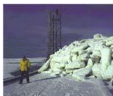
Quai endommagé par les glaces, quai Aboiteau, N.-B.
