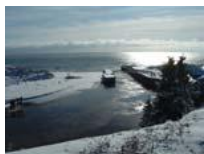
Dompage à l'infrastructure, Parc provincial Basin Head, Î.-P.-É.
